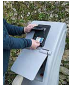
Borne monétique de puisage (source : ville de Vannes)
