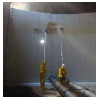
Lavage d'un réservoir (source : Herli)
