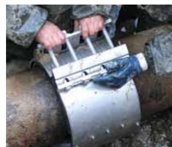
Installation d'un manchon de réparation (source : Norham)
