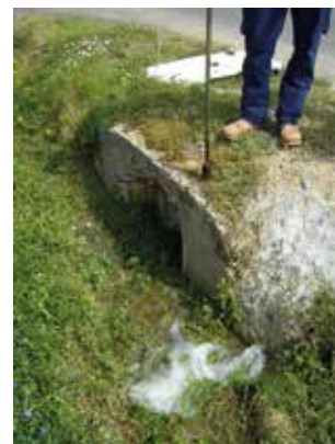
Réalisation d'une purge (source : Irstea)
